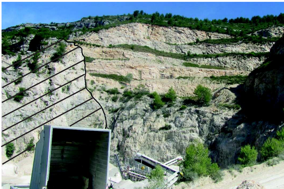
Délimitation de l'emprise du projet pour la conservation de la falaise
